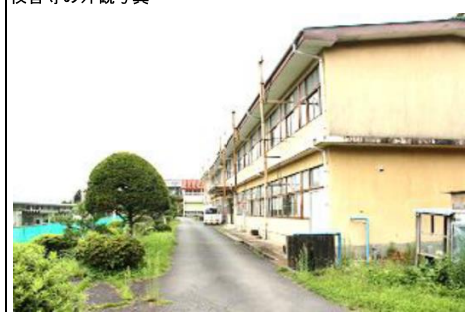
校舎等の外観写真
