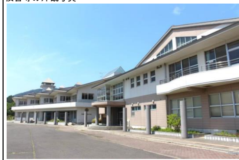
校舎等の外観写真
