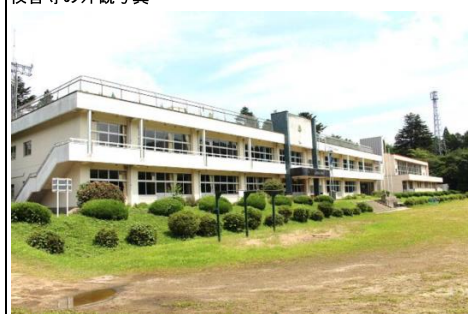
校舎等の外観写真
