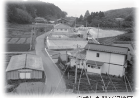
完成した登米沢地区
