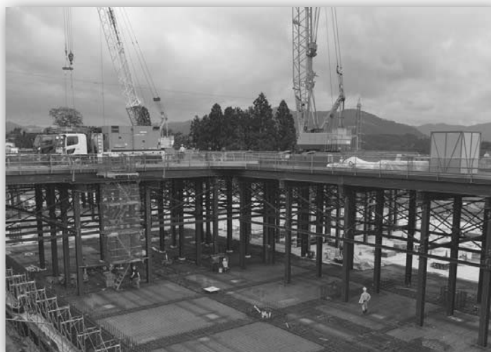
8月末の建設現場の様子
