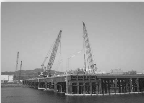
三陸沿岸道路気仙沼湾横断橋（仮称）の工事の様子
