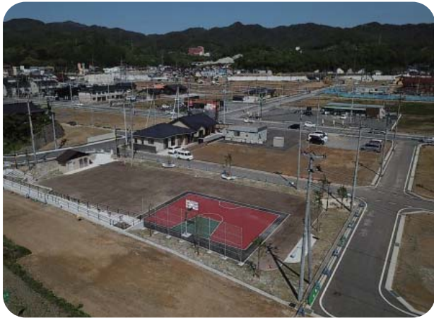
◀ 整備中の西みなど町公園
