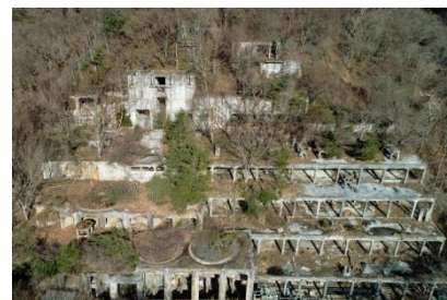
大谷鉱山巨大洗練所跡（宮城県気仙沼市）
