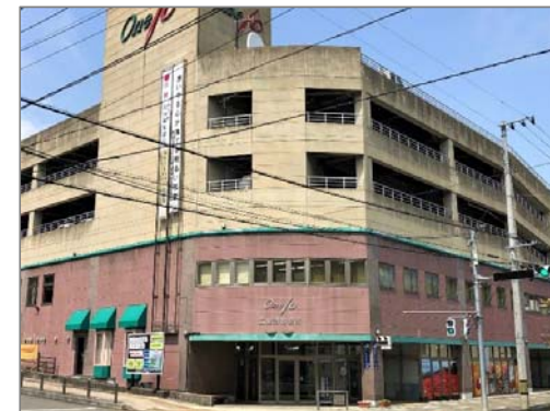
3. 11浸水部分(ワン・テン庁舎)
