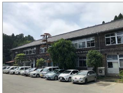
建物の老朽化(第2庁舎)
