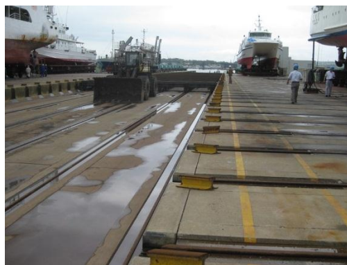
縦行レールを引くローダー
