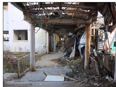
・現在（総合実習棟入口より見通す）
