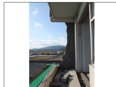
・現在（通信実習室より見る）
