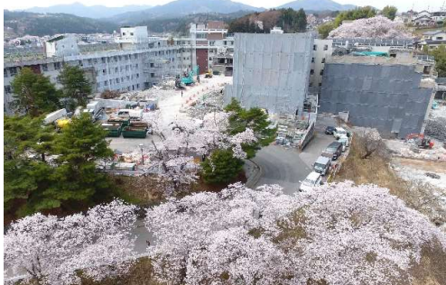
令和5年4月6日現在の状況 看護専門学校の上屋解体を終えて、増築棟と中央診療棟の躯体解体を行なっています
