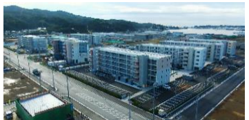
鹿折南住宅（災害公営住宅）
