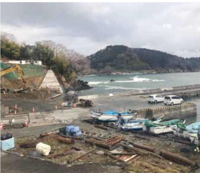
防潮堤を整備中の館漁港
