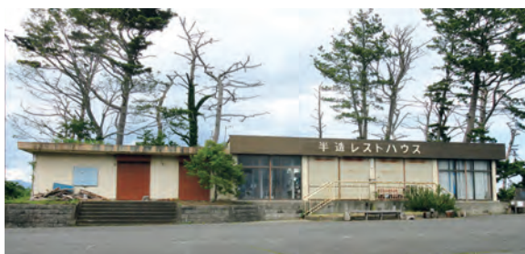
築55年が経過する半造レストハウス
