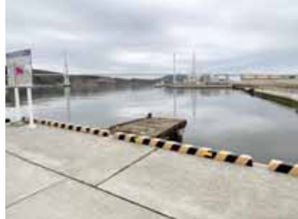
大水深岸壁整備予定地(潮見町)
