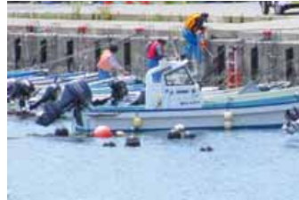
物揚場にはしごを設置し作業を行う
