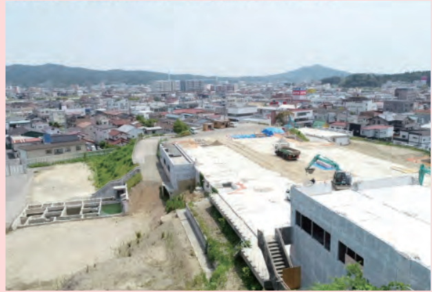
新庁舎建設地現況写真(敷地北西角より撮影)
