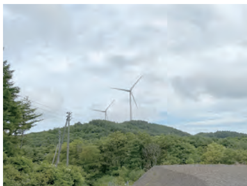
市民の森に既設の風力発電所
