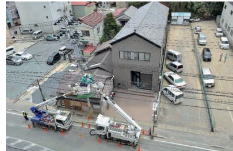
復旧対応に当たる電力会社
