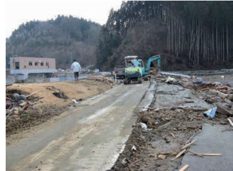
津波で被災した道路の応急工事
